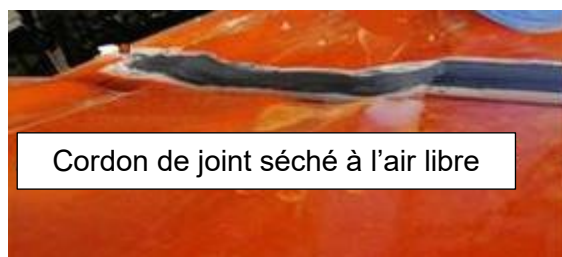
Figure 4 : Application du joint séché à l'air
